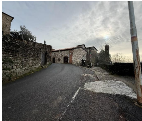
7 percorso in asfalto in salita
