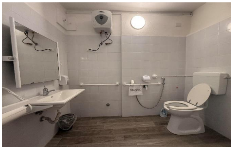
29 bagno attrezzato con sanitari accessibili
